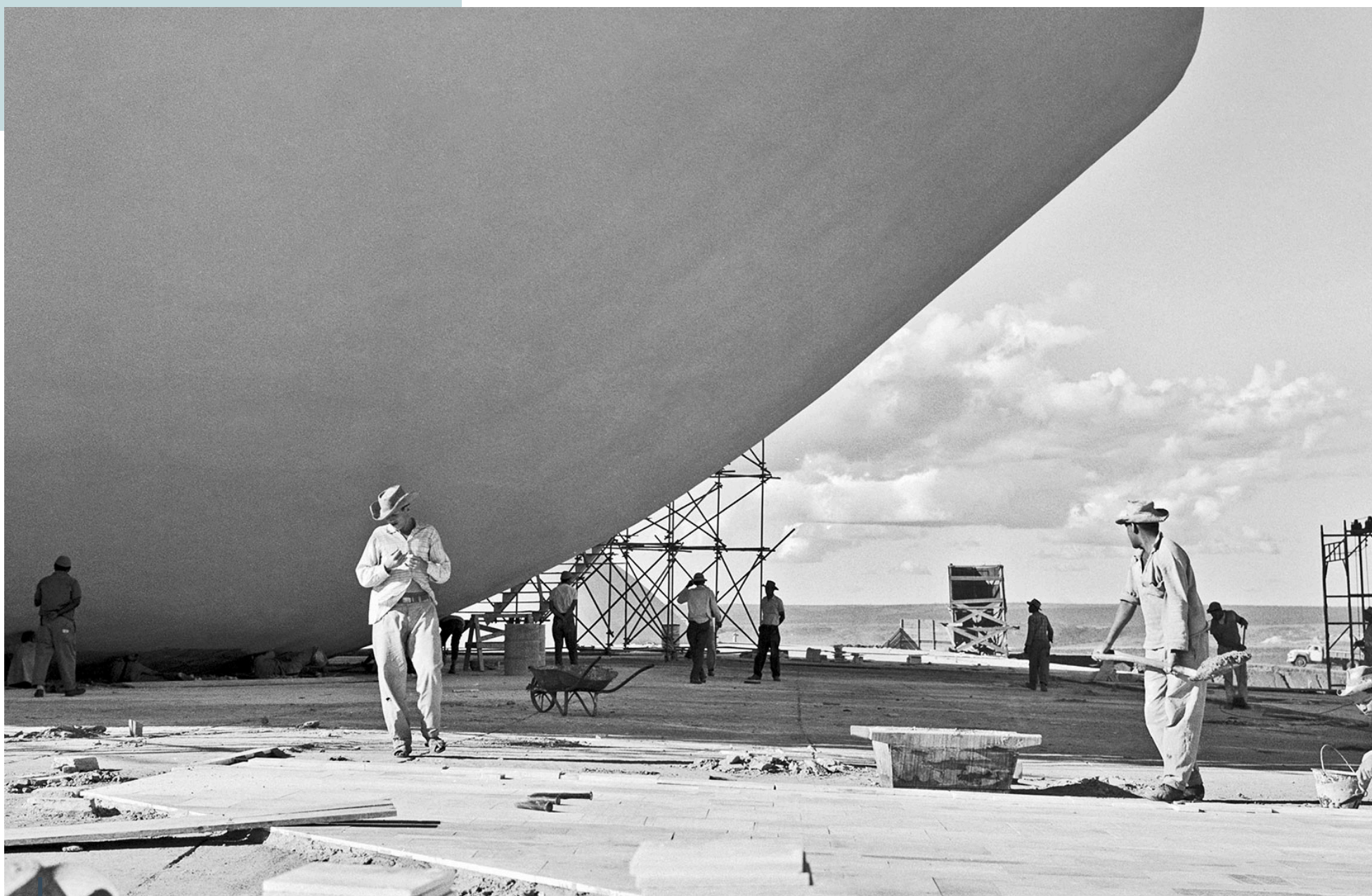
Trabalhadores nas obras do palácio do Congresso Nacional em fase de concretage c. 1959. Marcel Gautherot/ Acervo IMS
